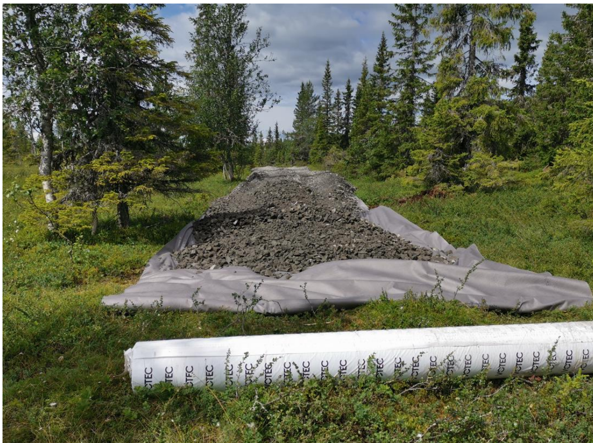
Turvegen mellom Sjusjøevegen og Natrudstilen ble ferdigstilt høsten 2022.
